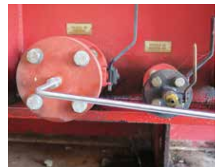
图 1. 安装的在线 DGA 监测系统 OPT100。进油管 and 出油管连接到底部的排放阀。
