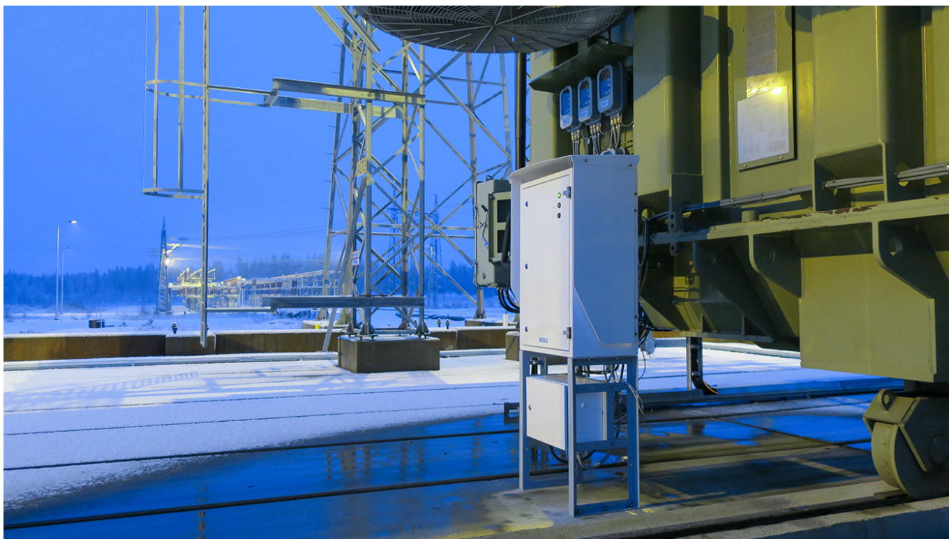
Optimus DGA 监测系统是在恶劣环境下保护关键变压
