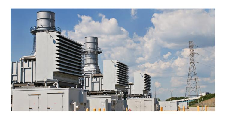
确保燃气轮机以最高效率运转是操作员的首要目标。在当前的经济环境下,任何能提高生产率进而提高利润的做法显然都很受欢迎。从环境角度看,燃气轮机尽量高效运转和减少排放量也很重要。幸运的是,有几种方法可以提高燃气轮机的输出功率。其中最重要的是,控制燃烧室入口空气的湿度和温度,因为这会直接影响燃气轮机的效率、排放和运转可靠性。
