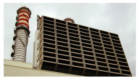
可使用准确的进气湿度测量增大涡轮机输出功率。
